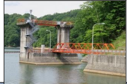
第二余水吐・連絡橋
