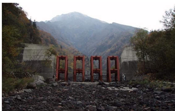
鋼製スリット砂防えん堤
