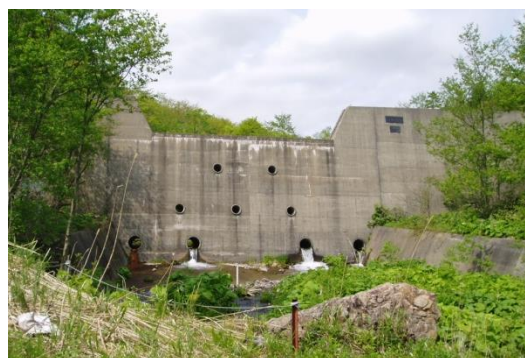
重力式コンクリート砂防えん堤
