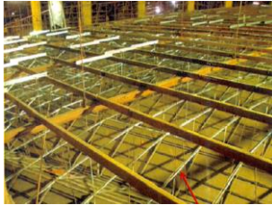
補強材設置
