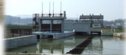
内水対策（排水機場を設置）
