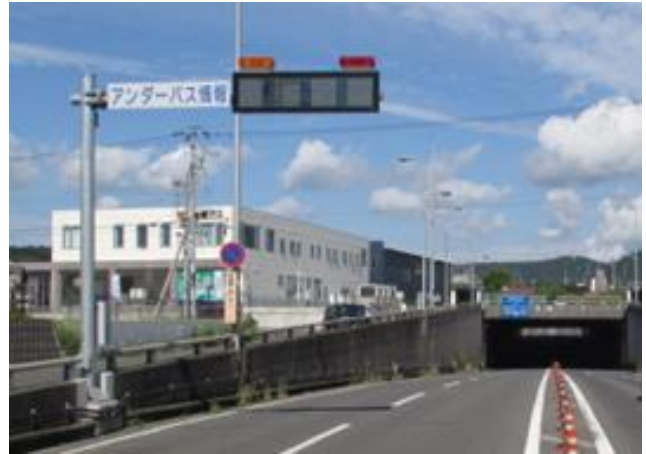
警報表示の設置例（道道室蘭環状線）
