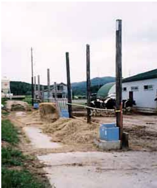
(写真1 パドックに設置した飼そう:電柱、コンクリート板で飼そうを作り、建物との間に電牧を張って低コストで作った例)
