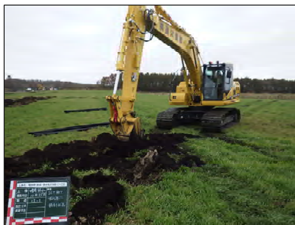
MGバックホウによる掘削
