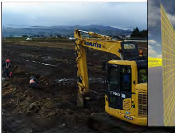
MCバックホウによる吸水渠掘削
