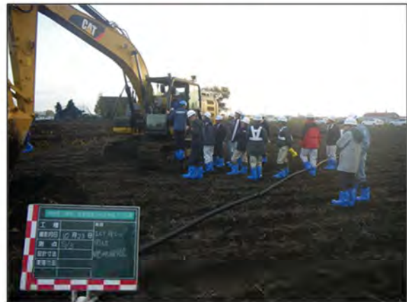
ICT施工 現地研修会
