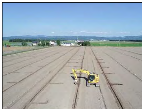
客土小運搬位置の割り出し
