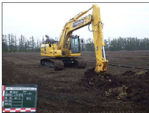
MGバックホウによる掘削
