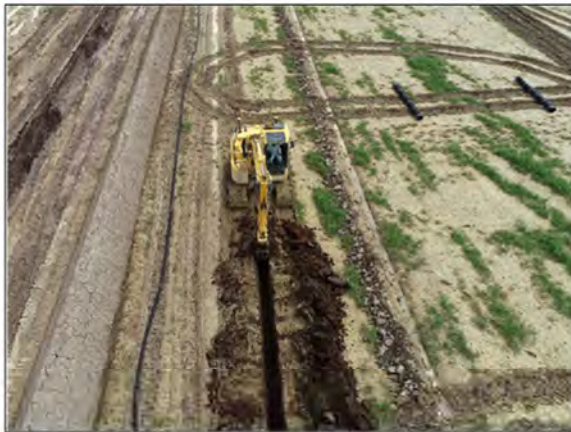
MCバックホウによる吸水渠掘削
