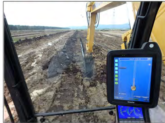
運転席のモニター画面で仕上がり状況確認
