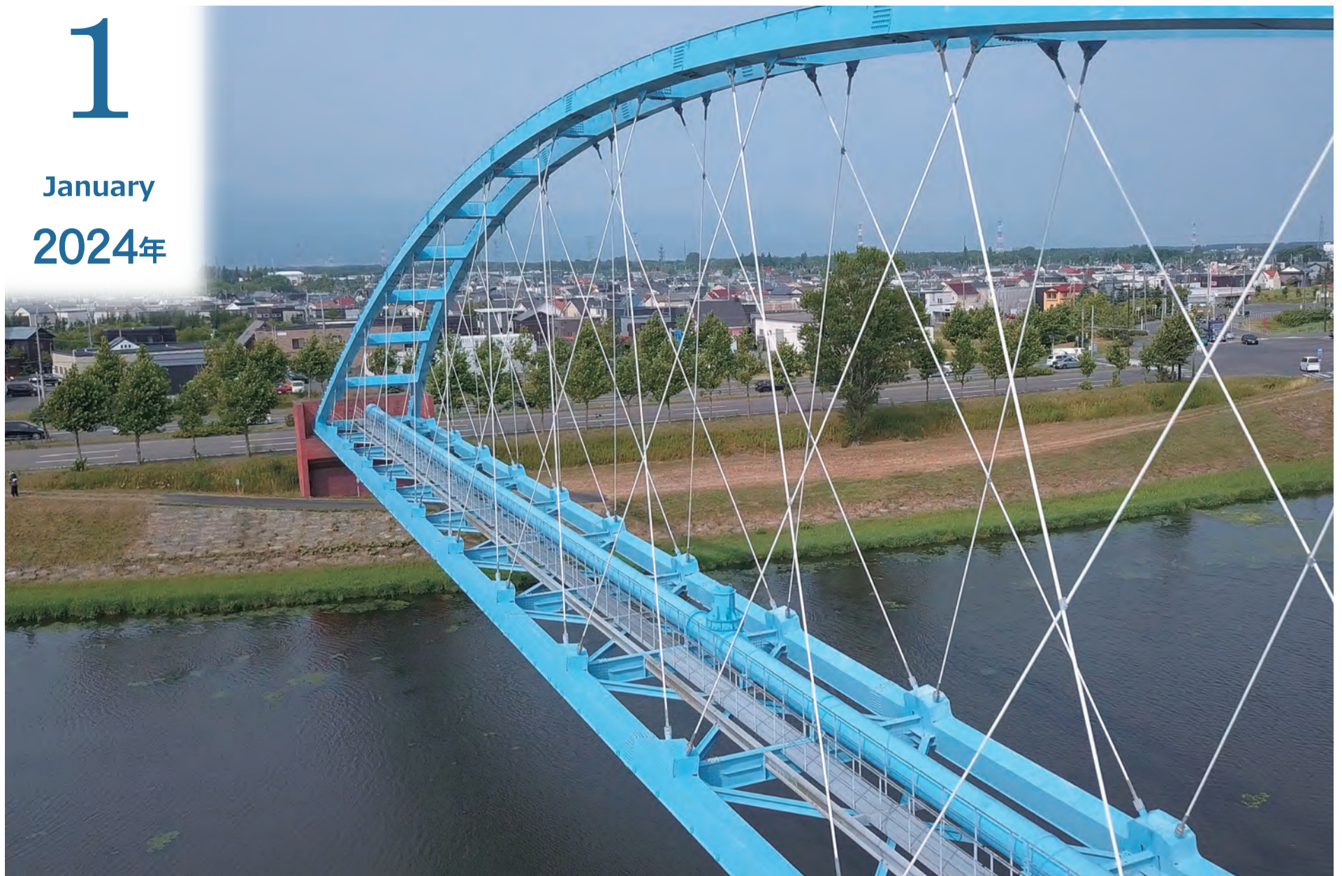
伏籠川水管橋(石狩湾新港地域工業用水道)
