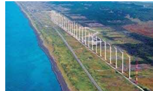
▲ オトンレイ風力発電所、幌延風力発電(株) (出典：NEDO)
