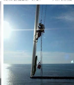
特殊高所技術によるブレード保守作業
