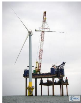
風車設置の様子
