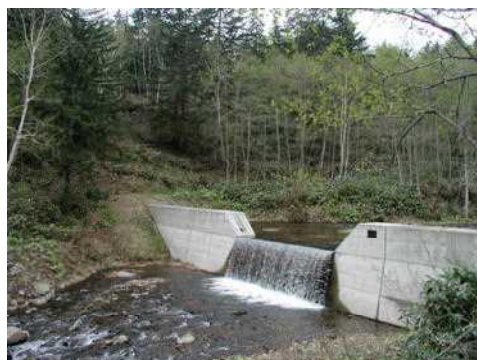
道有林内の治山ダム
