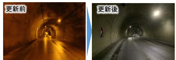
北見美幌線（美幌トンネル）（美幌町）
