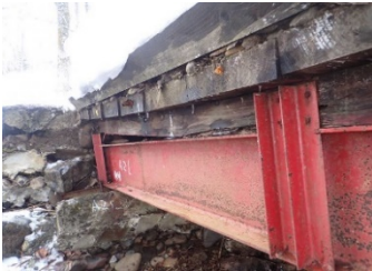
市道鷹泊三合沢線 (三合沢線橋) (深川市)
