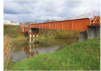
村道中島公園線 (中島橋) (音威子府村)
