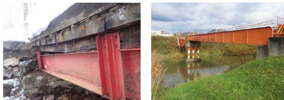
市道鷹泊三合沢線 (三合沢線橋) (深川市)
