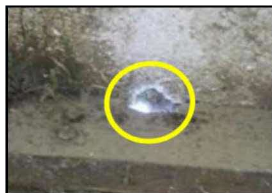
壁等の破損修繕
