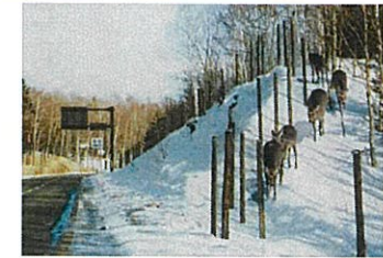
エゾシカ侵入防止柵
