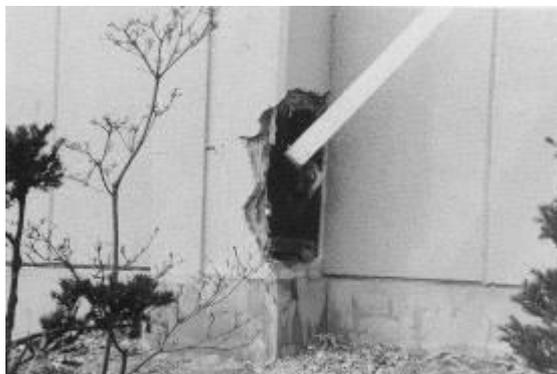
写真 3-5 筋違の破断
