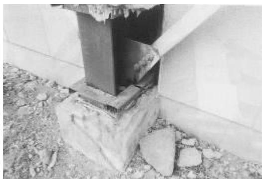
写真 3-9 柱脚コンクリートの部分破壊
