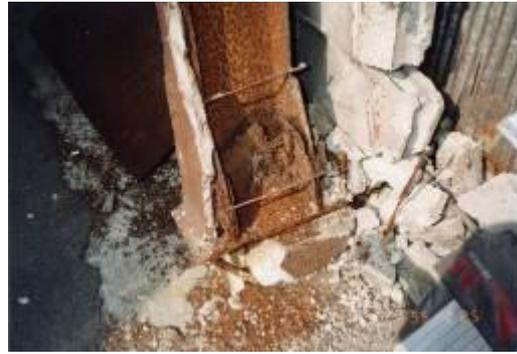
写真3-11 柱脚の腐食(Cランク)
