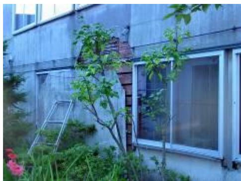
写真 2-19 モルタル壁の剥落 (B ランク)
