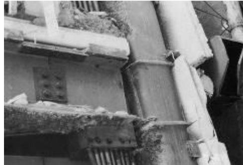
写真 3-7 梁仕口部の溶接部分の破断
