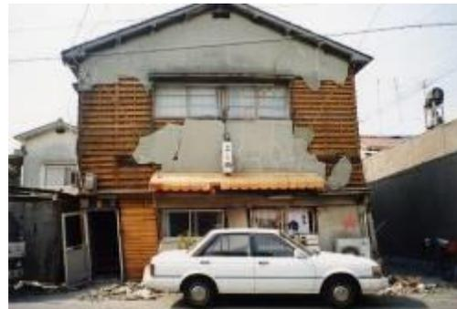
写真 2-11 外壁の被害(Cランク)
