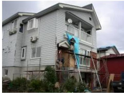
写真 2-20 サイディングの落下(Cランク) 写真 2-21 サイディングの損傷(Bランク)
