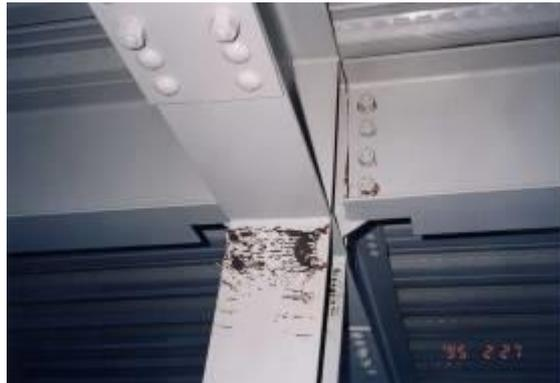
写真 3-4 柱頭の座屈による塗料の剥落 (B ランク)
