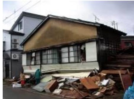
写真 2-2 低層階の崩壊
