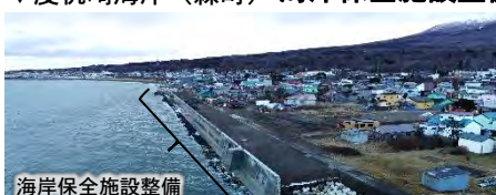
海岸保全施設整備
