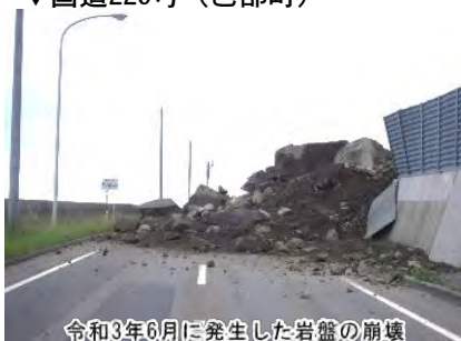
令和3年6月に発生した岩盤の崩壊
