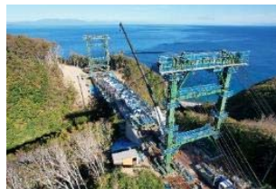
施工状況（新深歌橋）
