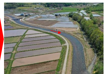
河道掘削・堤防の整備状況
