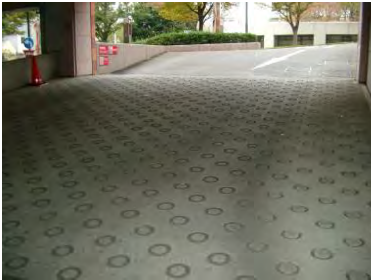
地下駐車場へのスロープの騒音対策 駐車場のスロープ部分はコンクリート舗装部分に滑り止め対策を講じ、走行車両のタイヤから発生する騒音（タイヤの横すべりによる軋 きし み音）を低減している（特にカーブ部分）。
