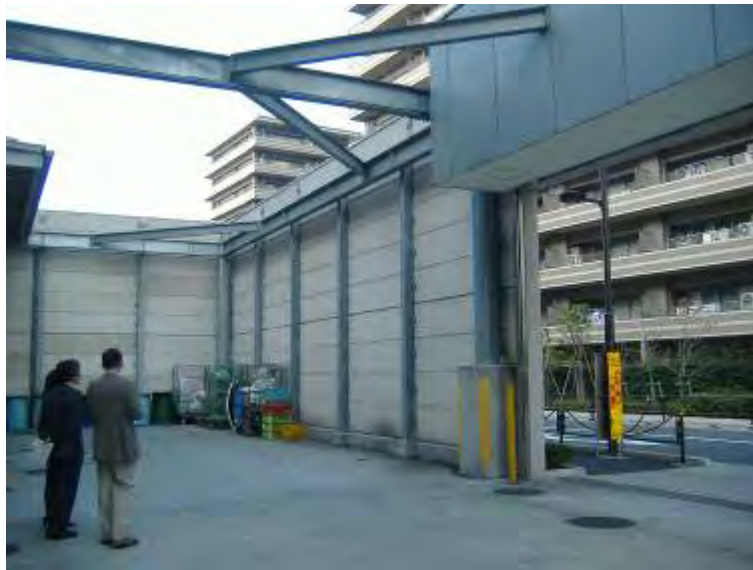
トラックヤード 防音壁、シャッター
