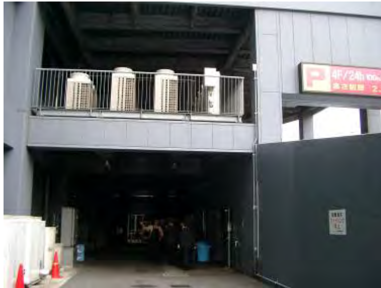
荷さばき施設と上部に設置した設備機器類
