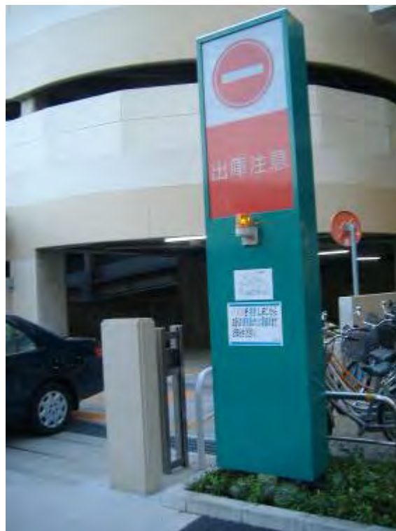
車出入口 グレーチングと出庫表示灯(消音)
