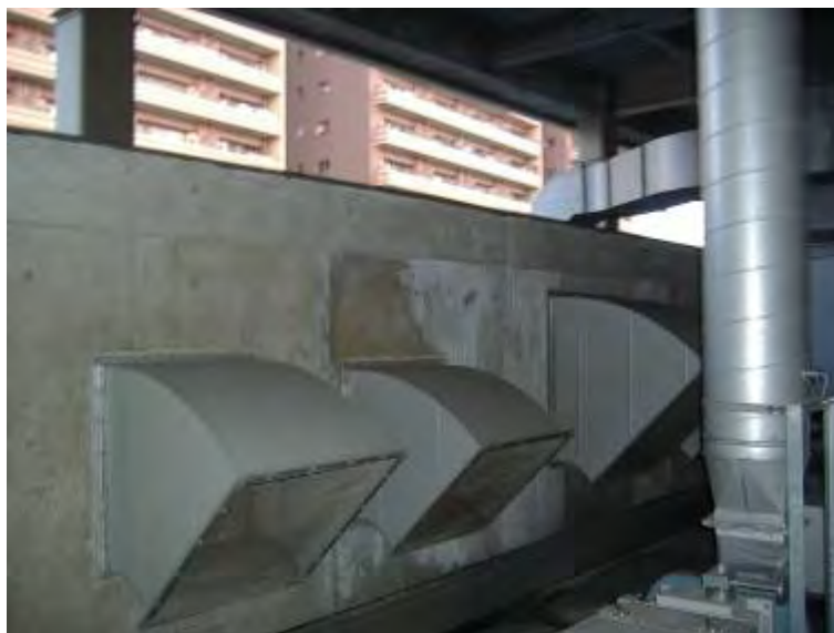
空調室外機置き場 ダクトの吹出し方向
