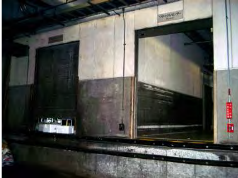
屋内（地階）に設置したごみ収集場 ごみ収集場を屋内（地階）に設け、外部への騒音伝搬を防止している。
