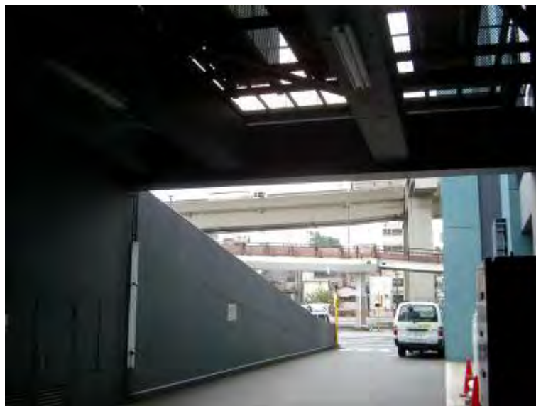
荷さばき施設の搬入口
