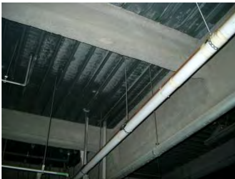
地下駐車場天井部分の騒音対策
