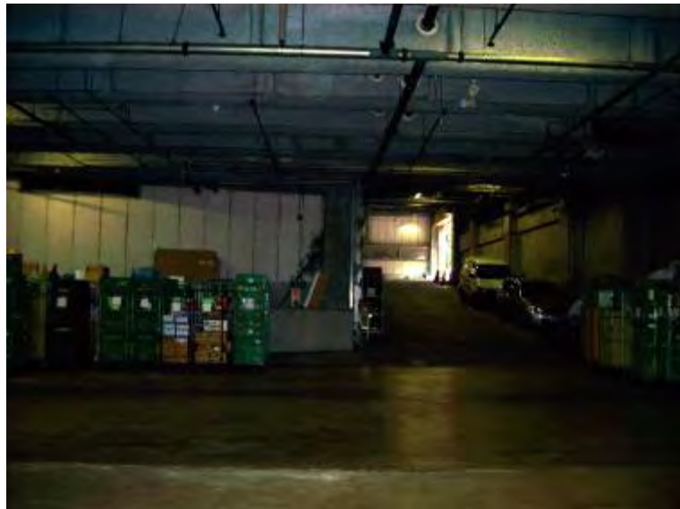
屋内（地階）に設置した荷さばき施設 荷さばき施設を屋内（地階）に設け、外部への騒音伝搬を防止している。
