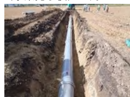
パイプライン化(施工状況)の用水路
