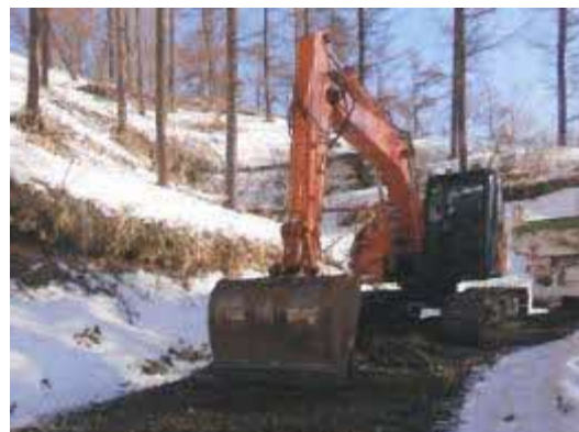
作業道補修作業
