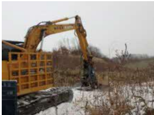
作業道補修実施状況
