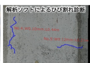
撮影写真からコンクリートのひび割れを自動検出し、幅・長さをデータ化
