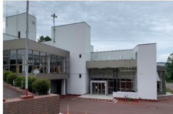
公民館(安平町) 公民館を避難施設へ活用(耐震改修、非常用電源対策等)
