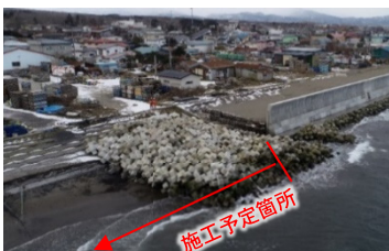
度杭崎海岸(森町) 施工予定箇所
