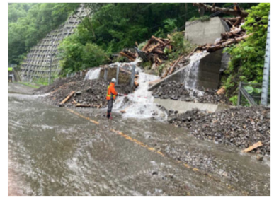
国道274号 日勝峠 (日高町)
