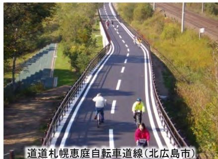
道道札幌恵庭自転車道線（北広島市）
