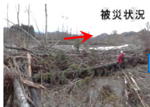
平成23年9月台風による被害状況
