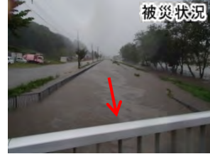
平成28年8月豪雨による被害状況
