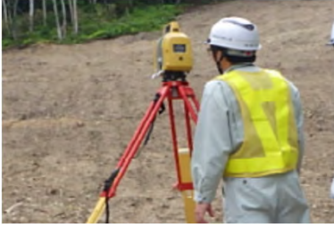
地上型レーザースキャナー(TLS)計測
