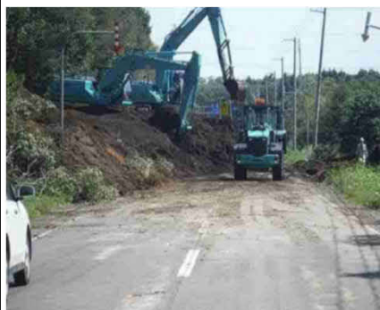
胆振東部地震 道路啓開作業(千歳鶴川線)
