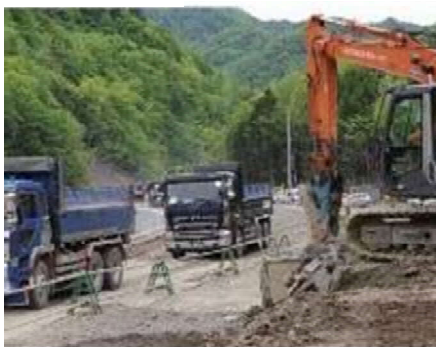
H28. 8月台風 道路復旧作業(国道274号) 国土交通省HPより
