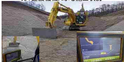
掘削状況モニター確認 掘削状況モニター
