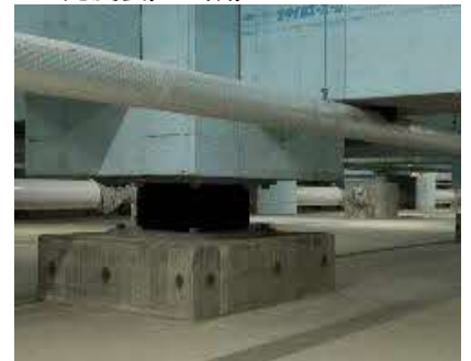
▼免震装置の設置
