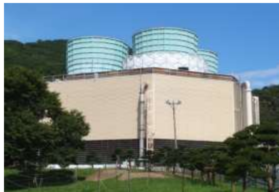
北海道電力(株) 森地熱発電所
