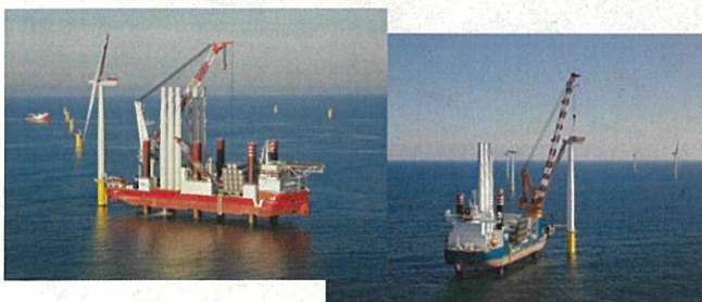
【洋上風力発電施設の建設】
