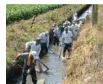
水路の泥上げ
