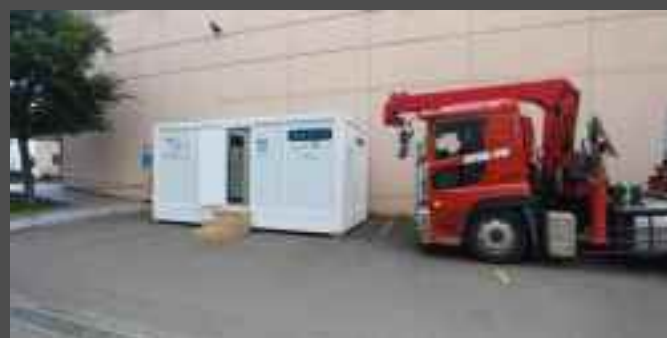
到着後15分で設置完了
