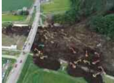
土砂撤去作業 (厚真町)
