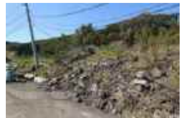
【厚真町吉野地区】斜めになった電柱
