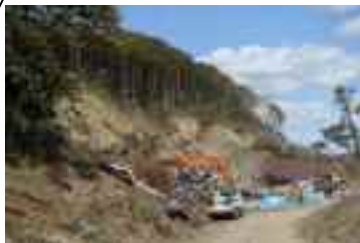
【厚真町吉野地区】土砂崩れ被災現場
