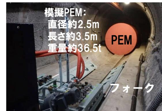
フォークをPEMの下に差し込み、エアベアリング(空気力で浮かすこと)で持ち上げ、模擬PEM(約36.5トン)を動かします。
