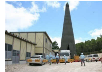
地上からのボーリング調査
