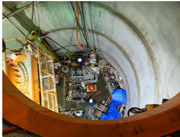
東立坑 (平成28年6月8日撮影)
