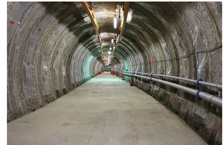
深度350m調査坑道 東周回坑道 (平成28年6月28日撮影)
