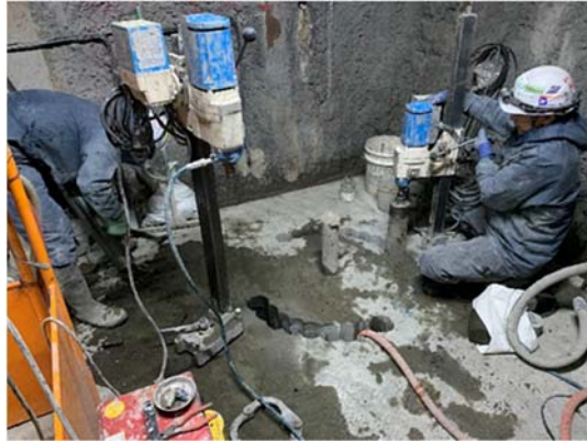
(a) スリットの掘削
