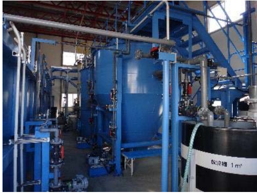
硝酸性窒素処理設備
