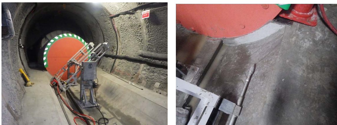
写真 6 ウォータジェット方式の装置とノズル
