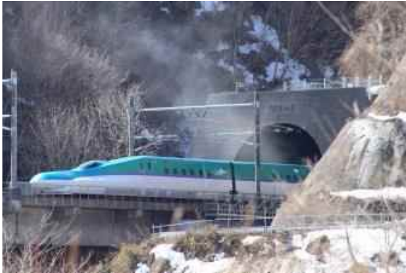
青函トンネル 北海道側出入口
