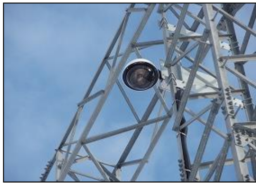
保守情報伝送装置（左）と屋外カメラ（右〔変電所鉄構取付状態〕）
