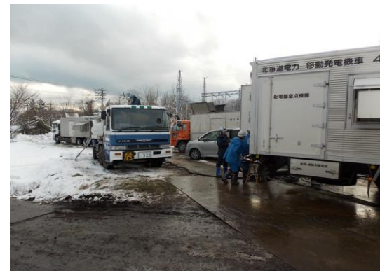
移動発電機車による供給
