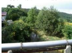
樹木が繁茂した河道状況
