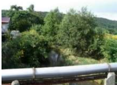
樹木が繁茂した河道状況
