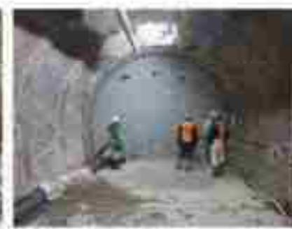
切り欠きの掘削とプラグの施工例
