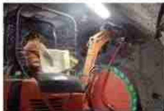
オーガー掘削による隙間充填材の除去
