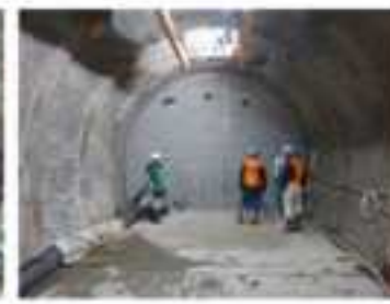
切り欠きの掘削とプラグの施工例
