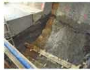
切り欠きの掘削とプラグの施工例
