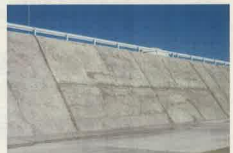
防潮堤(約1,000m)
