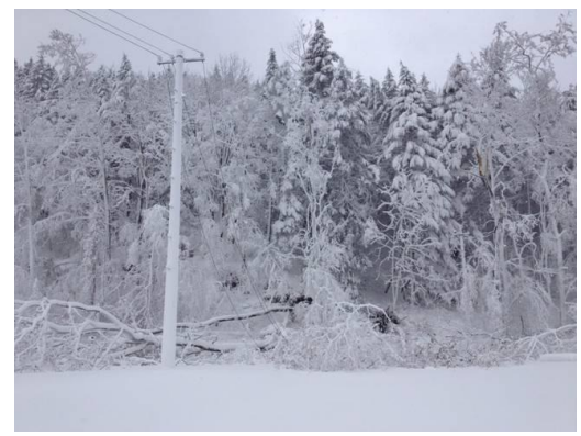
樹木倒壊による 高圧線断線
