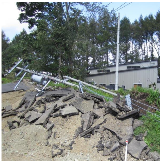
倒壊した柱上変圧器柱
