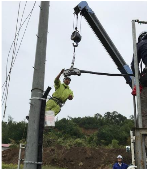
高圧ケーブルによる応急送電
