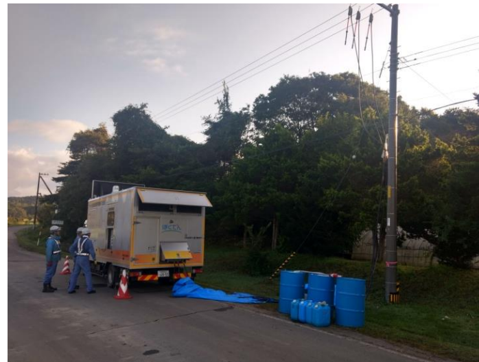
移動発電機車による応急送電
