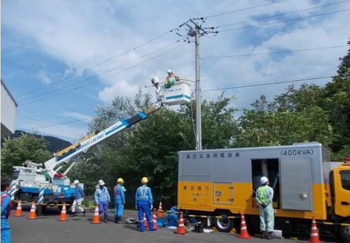
配電線への接続作業中の東北電力発電機車
